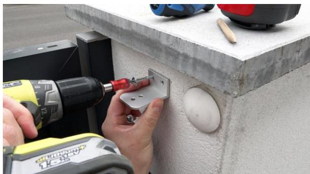
Después de haber instalado los tacos, hay que fijar la escuadra 1 con los tornillos. Asegúrate que los tornillos sean aproximadamente 10 mm más largos que los tacos utilizados.
